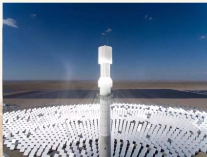
鲁能海西州格尔木海西州 50MW塔式光热发电
