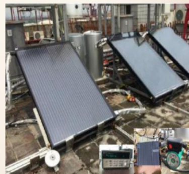
真空玻璃盖板及真空玻璃盖板PV/T
