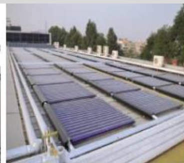
图 2 太阳能集热器安装
