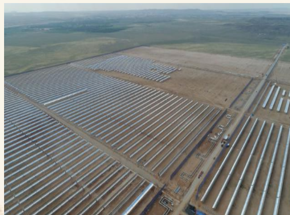
内蒙古乌拉特中旗100MW槽式太阳能热发电站
