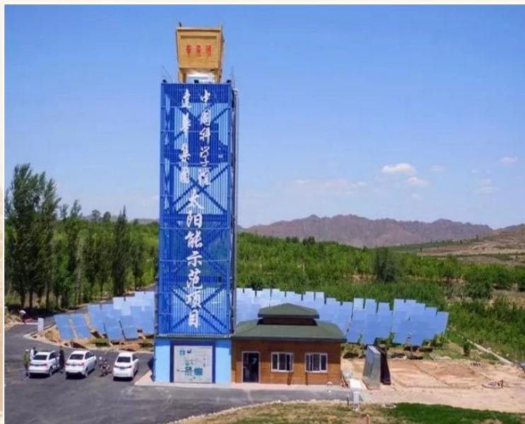
矾山黄帝城跨季节水体储热塔式太阳能供热示范系统
