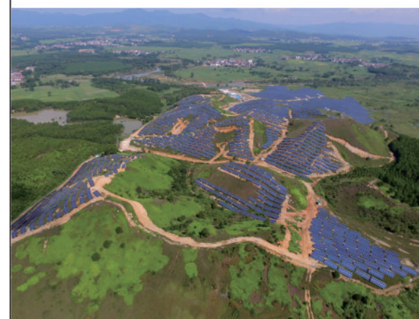
协鑫安福20MW光伏电站
