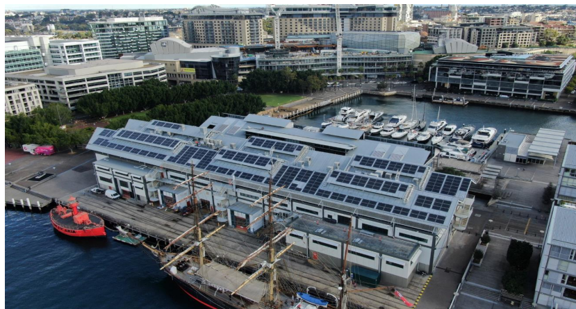
装机容量：235 KW，项目地点：澳大利亚
